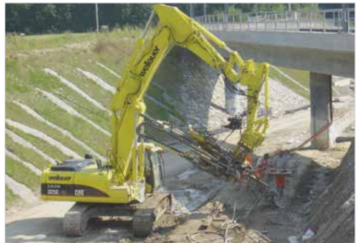
Hydraulikbagger mit Anbaulafette
