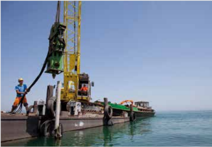
Stahlpfähle rammem ab Ponton
